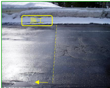
左側がひび割れ処理箇所
