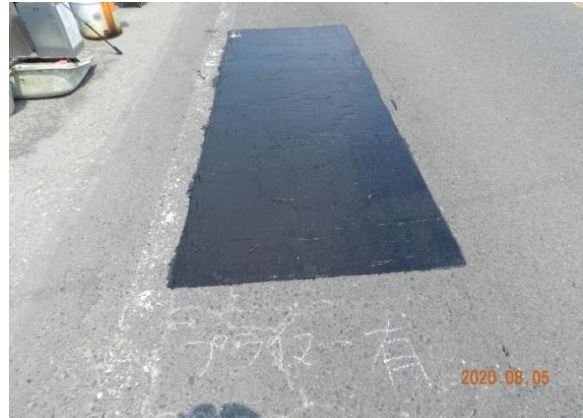
2) ラバクラックコートの塗膜防水
