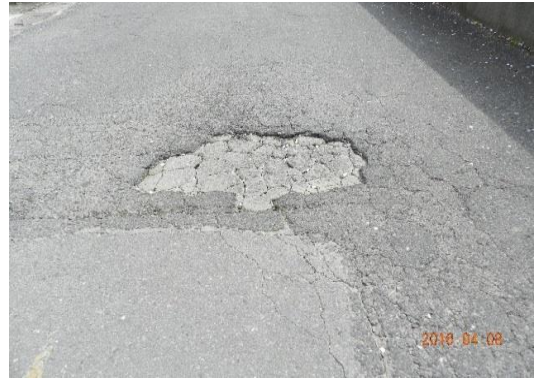
ひび割れ箇所（雨水などの滲入防止）
