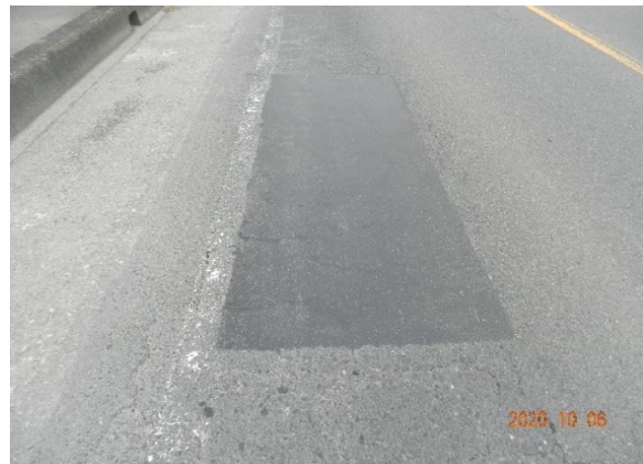
4) 施工後、2か月経過
