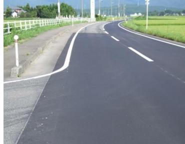
⑧舗装完了
