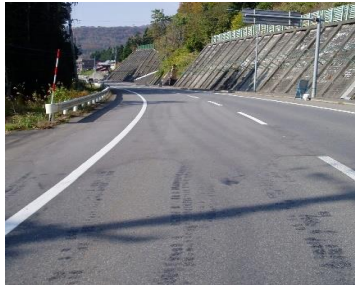
左側がひび割れ処理箇所
