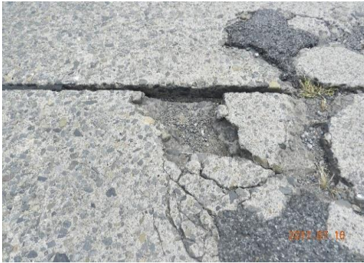
平坦部の亀甲状ひび割れ箇所
