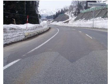
後方がひび割れ処理箇所
