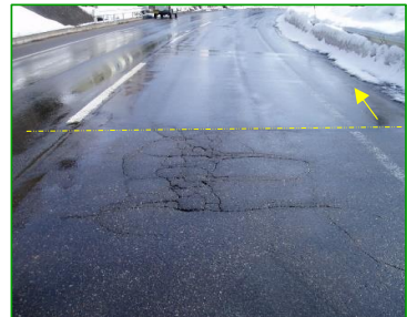
後方がひび割れ処理箇所
