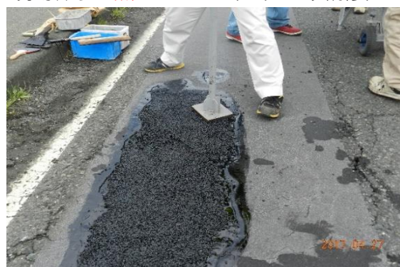
現場練り加熱アスコン (穴、凹み補修)
