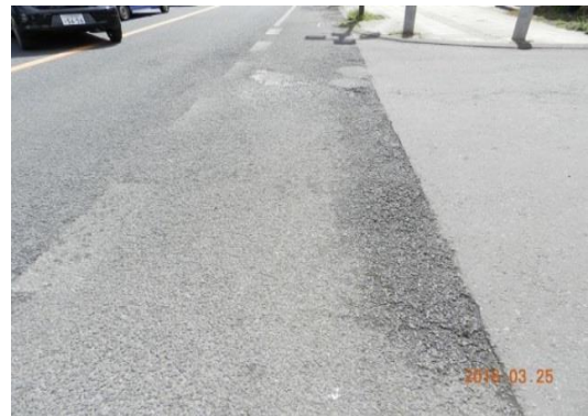
ジョイント部の損傷箇所
