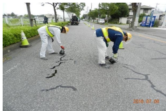
現場練り加熱アスコン (穴、凹み補修)
