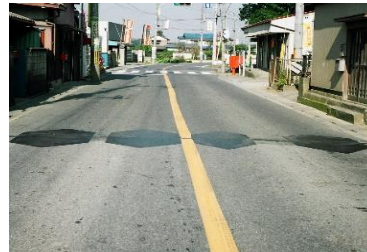
③ 施工後1年経過
