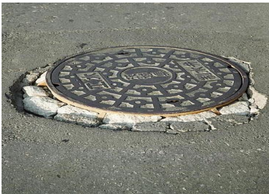
構造物周りの損傷箇所
