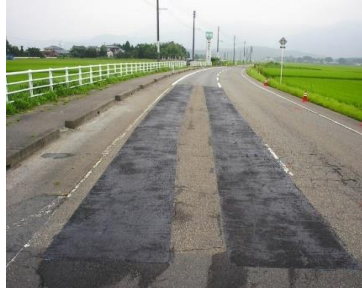
⑦塗膜防水層の仕上がり
