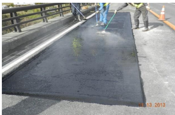
ひび割れの注入、シール (常温タイプ)
