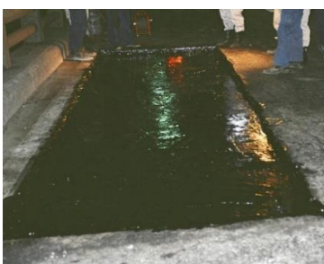
② ラバファルトの塗布
