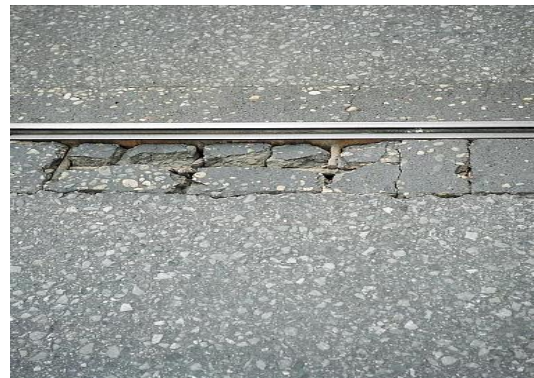
ジョイント部の損傷箇所
