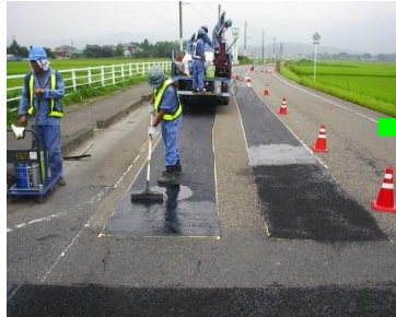
④ラバファルトの塗布
