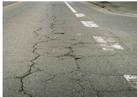
粗骨材の離脱箇所
