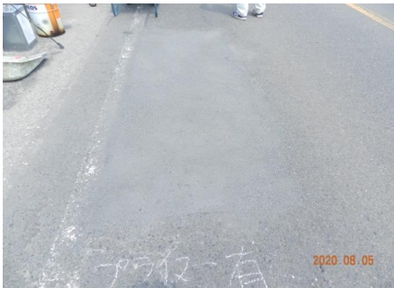
3) 養生砂（粗目砂）の散布、交通開放
