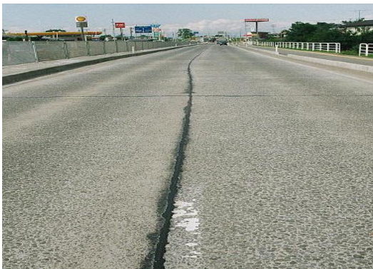
構造物周りの損傷箇所
